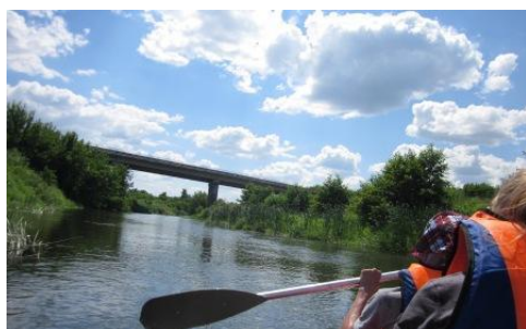
23.06.2016. Автомост в районе г. Аткарск
