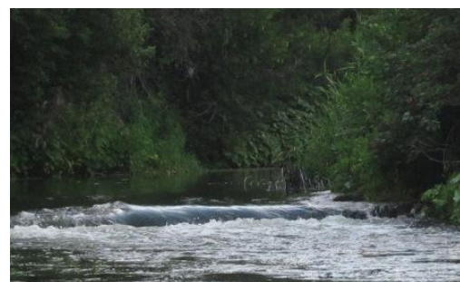
23.06.2016. Слив через трубу в с. Щербиновка
