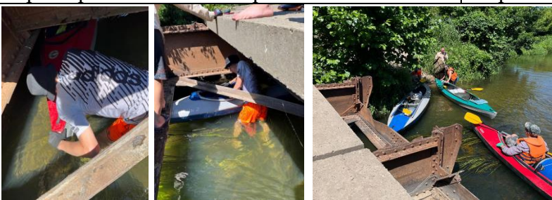
Низкий железный автомобильный мост с.Шербиновка, проводка байдарок под мостом
